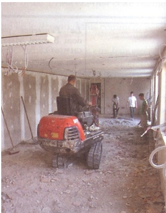
Travaux dans la future cuisine de l'hôtellerie
