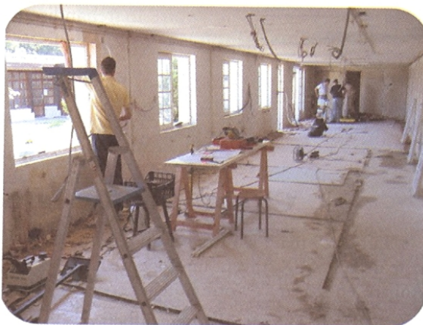
Travaux dans le réfectoire de l'hôtellerie
